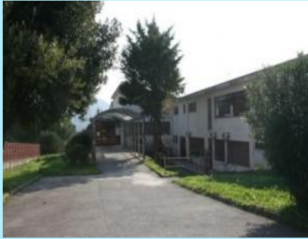
Plesso di Coperchia, via Nicola russo 7 Sede della Scuola Primaria di Coperchia Scuola dell'Infanzia Uffici Amministrativi
